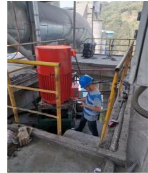
选粉机永磁电机直驱方式
